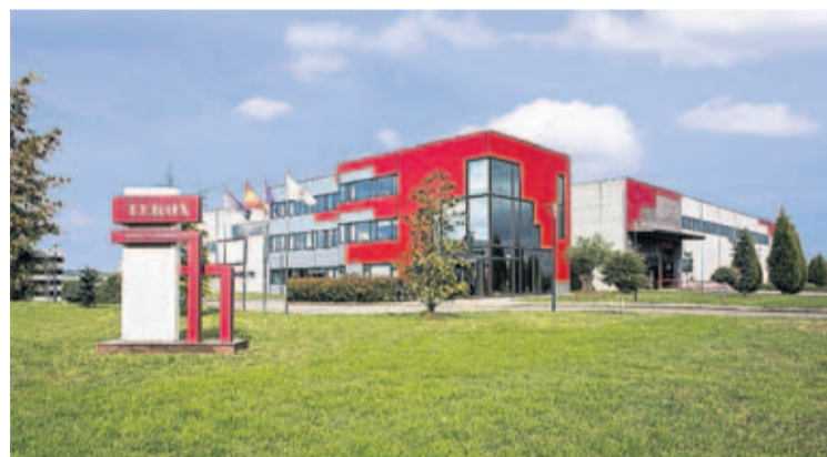
Las instalaciones de Tekox. | FOTO CEDIDA A LNE POR TEKOX
